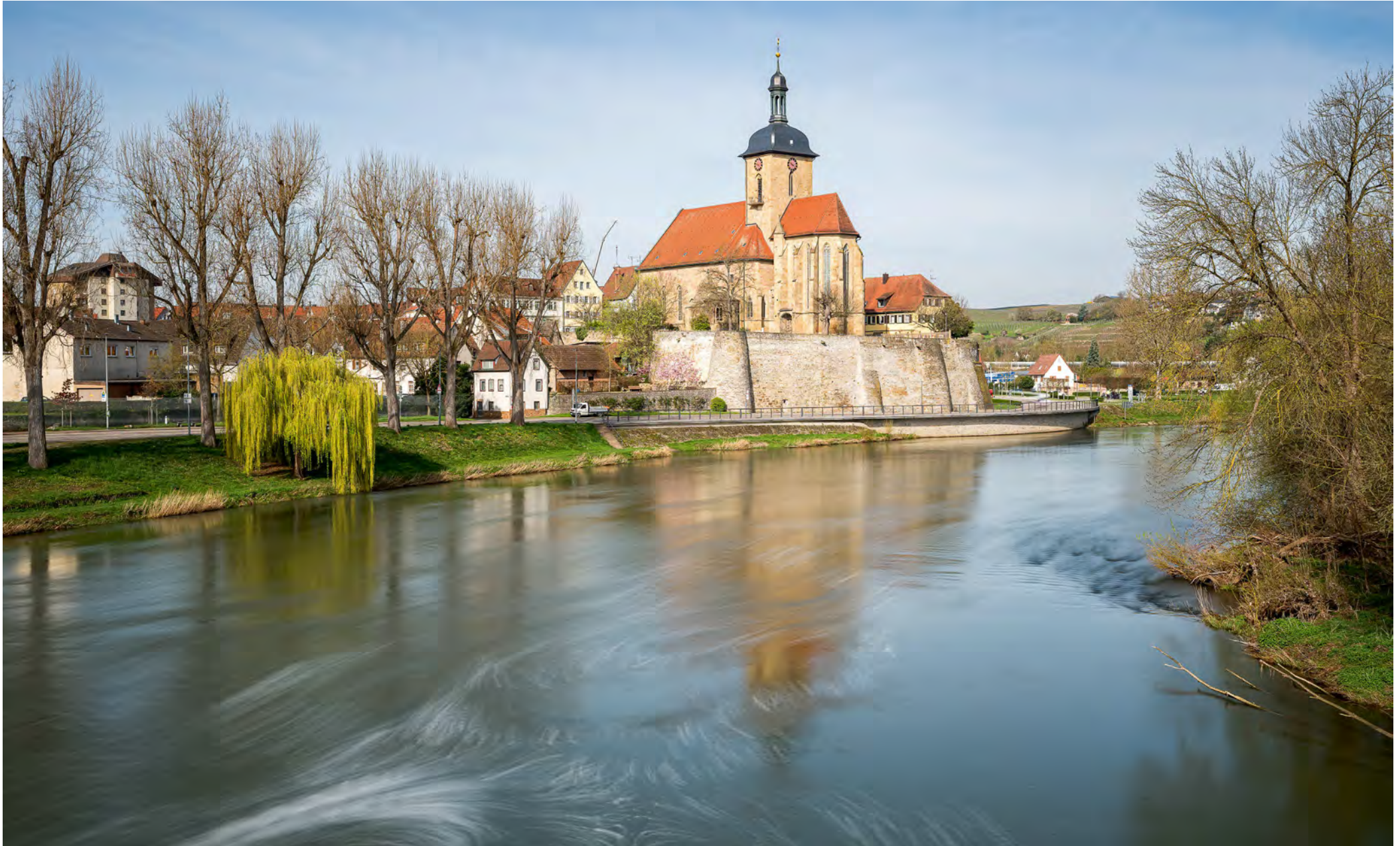
Südlich von Heilbronn passiert der Neckar die Geburtsstadt Friedrich Hölderlins, Lauffen a. N., mit einigen bedeutenden historischen Baudenkmalen – stellvertretend hier die im Mittelalter als Wallfahrtskirche dienende und heutige evangelische Regiswindiskirche.
